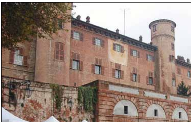
A lato il Castello, in basso i lavori che hanno interessato la camera da letto del Re
